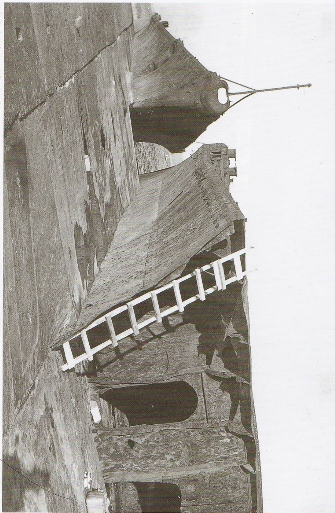
福岡県若松港の防波堤にされた「冬月」(左)と「涼月」(右)の各船体。ここに「涼月」の撮影構図は簡易な構造の船体を示す船体の角度で、甲板シーアや舷側ツレアがほとんど平面で構成されているのが実によく判る(撮影＝朝長浩)。
