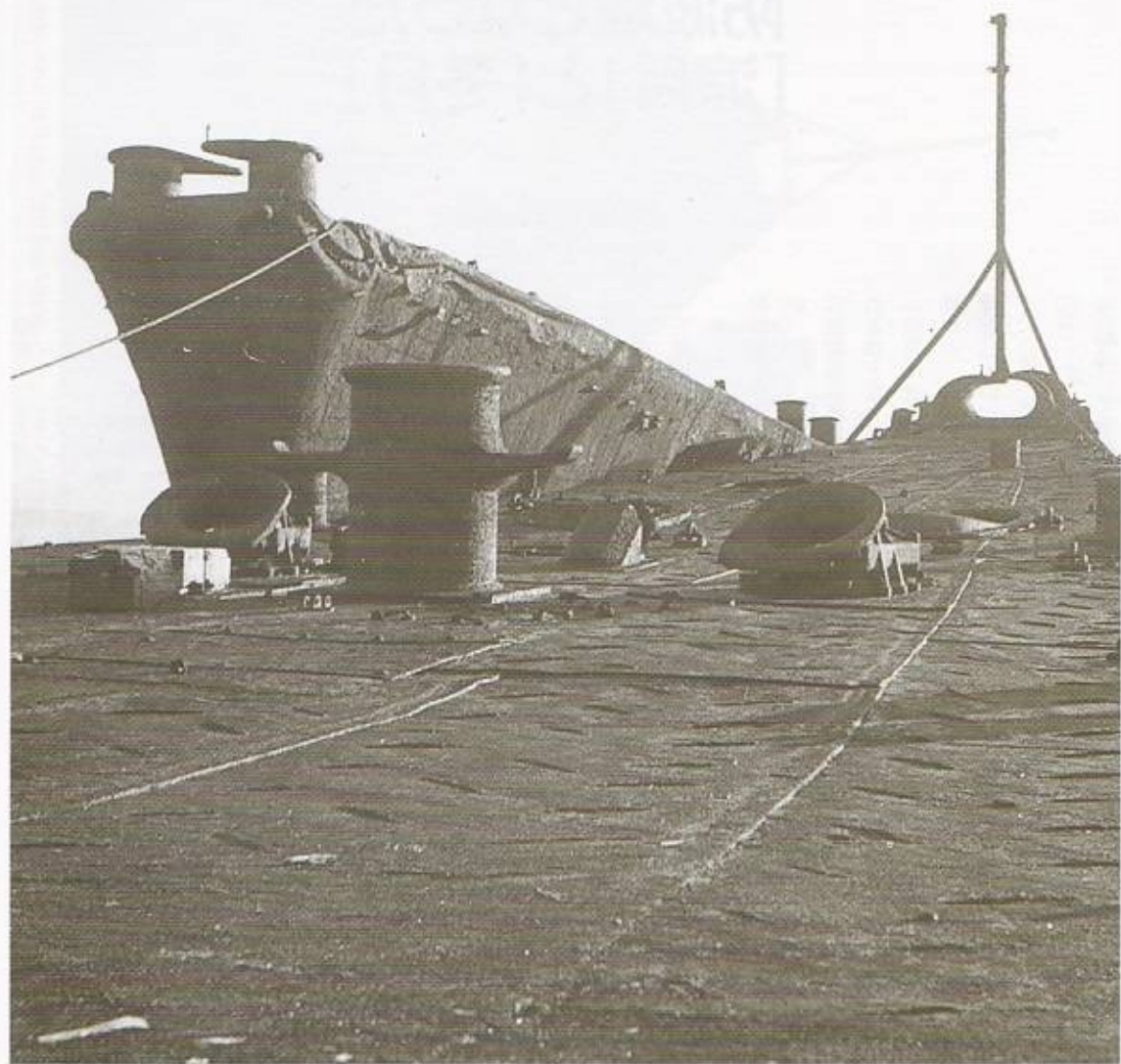
手前の船首楼甲板が「冬月」、左が「涼月」。「涼月」の艦首上部は平面に近い。フェアリーダームボラードの流用のようだ（撮影＝朝長浩）。
