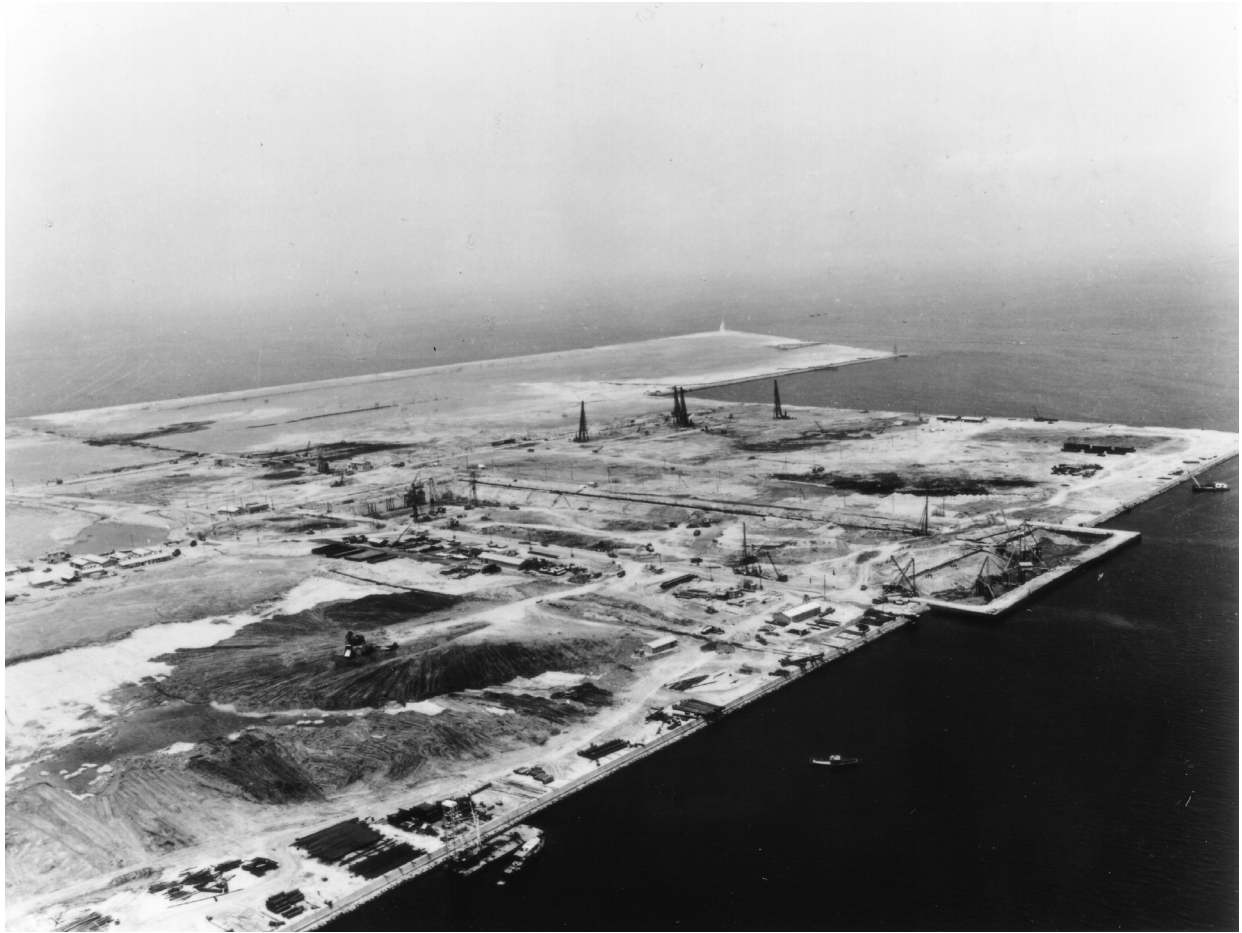
写真1 ドック建設が始まった原っぱのような新工場
