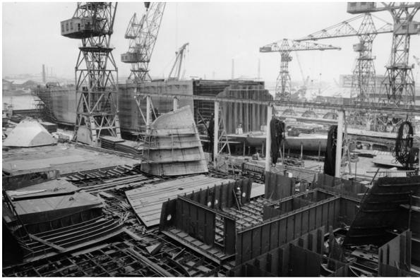
写真 4 17 型木材船建造中の船台と手前は屋外組立場
