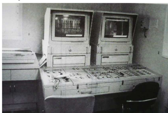
21) W69 - 21 鶴洋丸 荷役制御パネル
