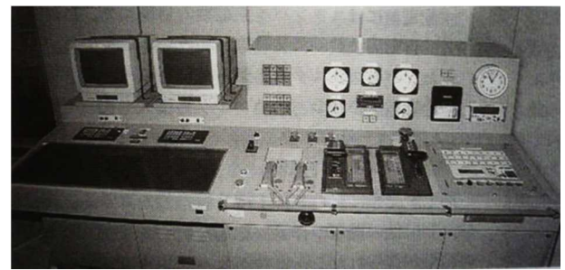
10) W70-10 はやぶさ 機関監視制御盤
