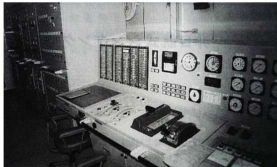
9) W7 1-0 9 BASLA 56 機関室制御コンソール
