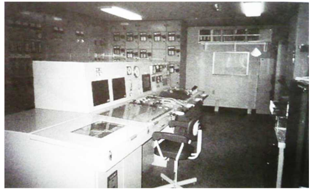
9) W72-09 やまと丸 機関制御室
