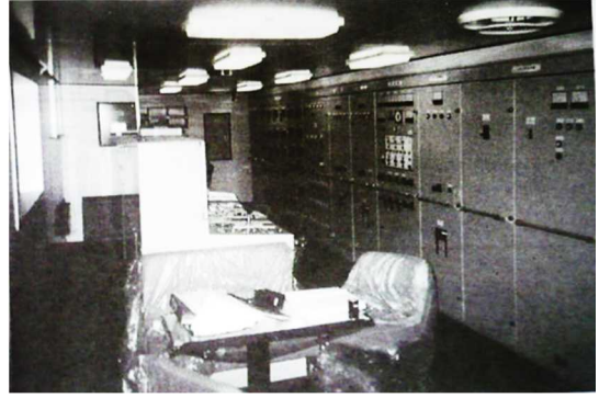
21) W74-21 第八すみせ丸 集中制御室
