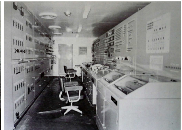
9) W47-09 山鶴丸 機関制御室
