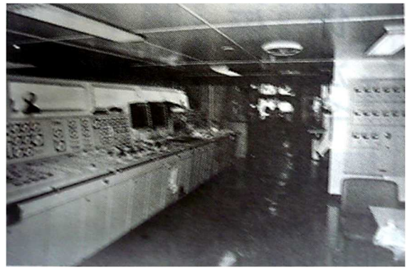
10) W61-10 東京丸 集中制御室
