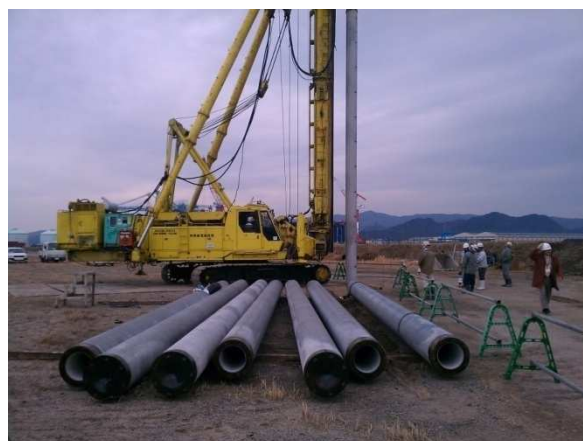
杭打工事状況
