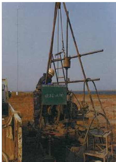
ボーリング調査状況
