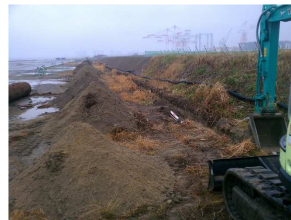
配線埋設工事状況
