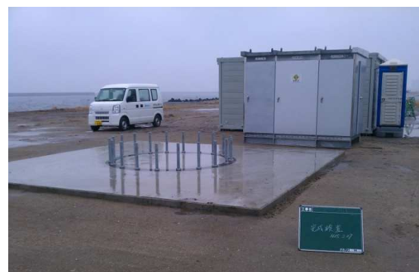
完成した基礎
