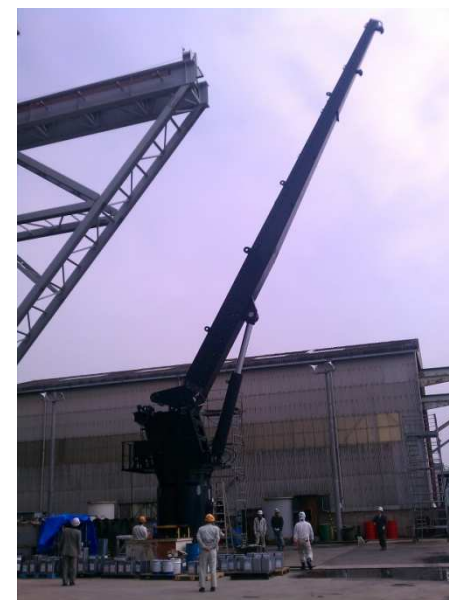
組立前動作確認の 状況
