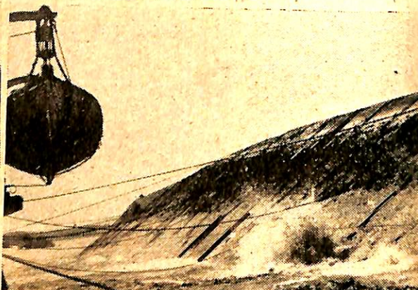
(8) 第一回引起急激に進む。船内圧縮空気盛に噴出す (本作業中最も壯観な一場面)
