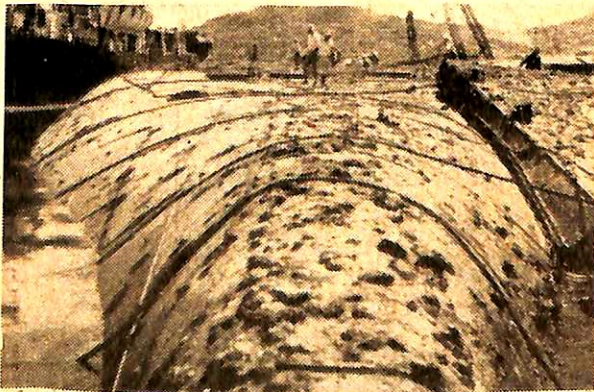
(3) 逆浮揚 船尾船底（スターンフレーム）上に 立つて前部を見た所
