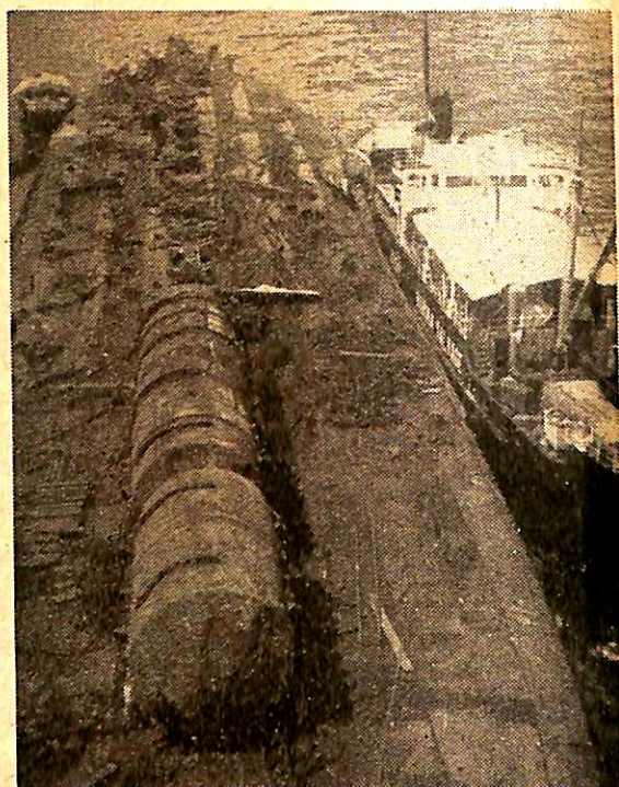
(6) バラストタンク取付中 右に見ゆるに母船君島丸
