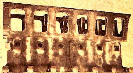
第 19 図 シリンダと架溝一体製のもの
