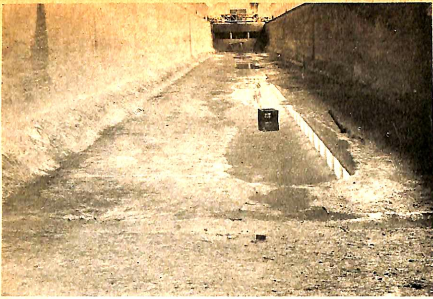
第4図 昭和28年5月、水を落して清掃を終えた大水槽前方曳引車の下に造波板が見える
