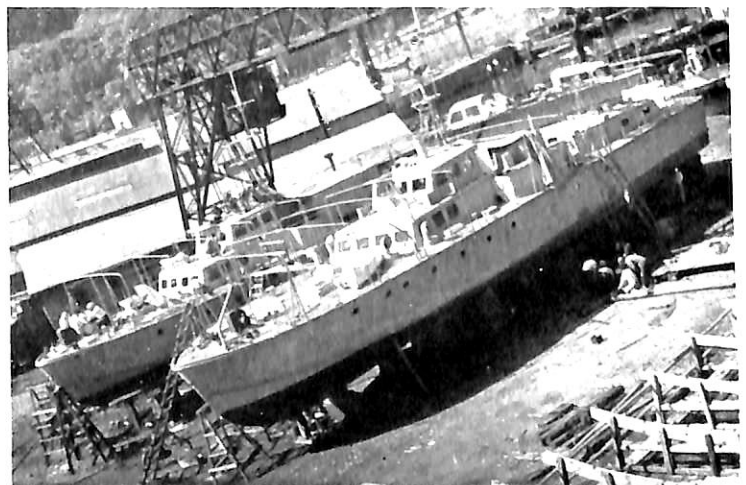
建造中の兩巡視艇
