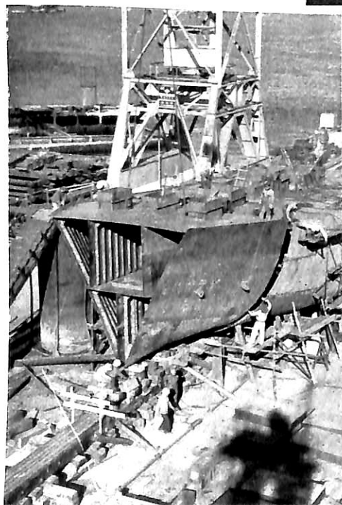
写真 3-3 前部ブロック取付工事
