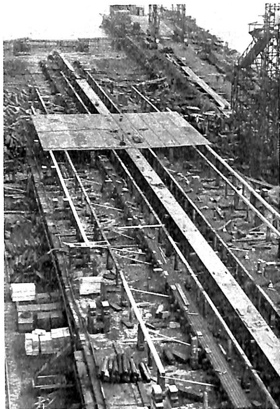
写真 1-1 底部外板取付 銲シームのため中央部より輪切りに取付けてゆく
