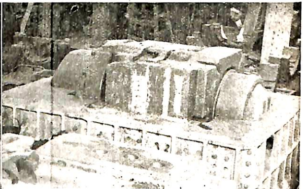
写真11 (b) シリンダジャケットの中子を 詰め終った状態
