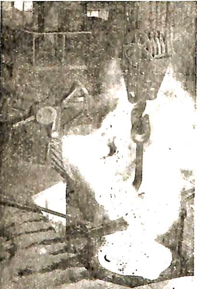
写真 18 → 鑄鋼の押湯 のガス切断 作業
