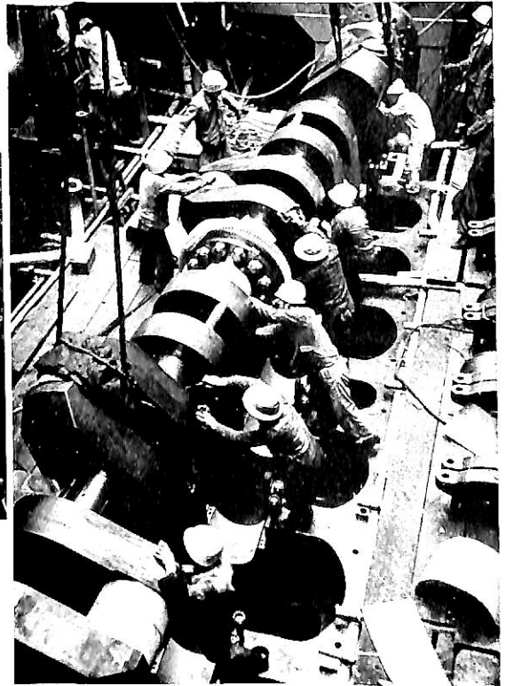
第9-15図 クランク軸納めの状況
