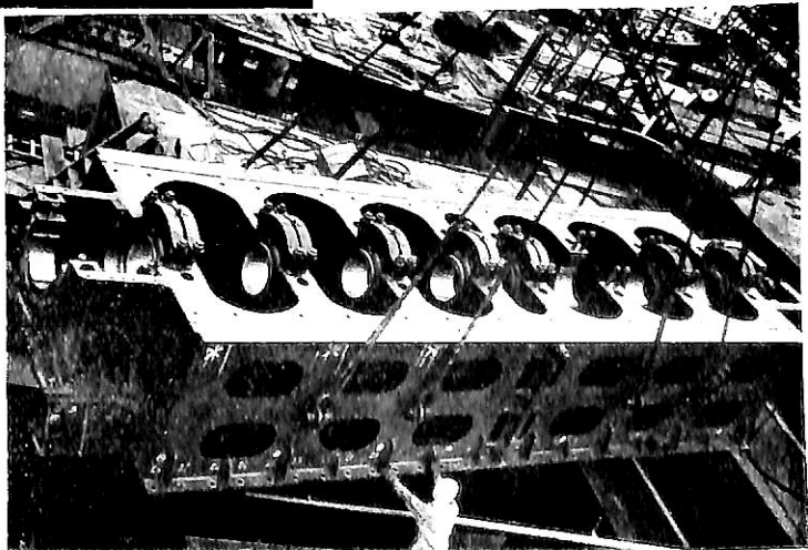
第9-13図 台板の積込み
