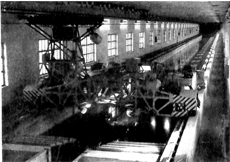
防衛庁目黒試験場の中水槽曳引車
