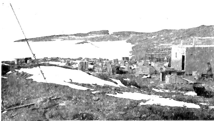
写真 2 建設中の昭和基地 (左の水平線の向うに見えるは南極大陸)
