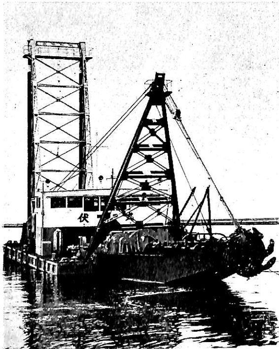
スベッドシヤーの上から船橋とラダーシヤーをみる ラダーの先端に6枚のカッターがついている
