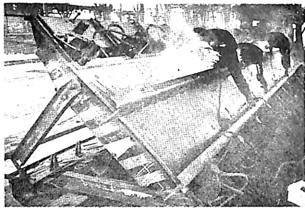
Fig. 6 廻転治具上における上甲板プレートと ロンジとの隅肉熔接施工状況
