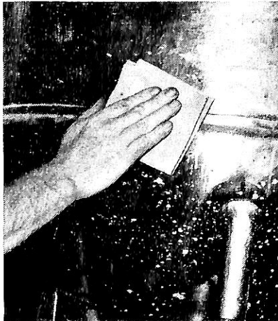
写真3 表面を完全にきれいにしやすりがサンドペーパーで表面を粗くする
