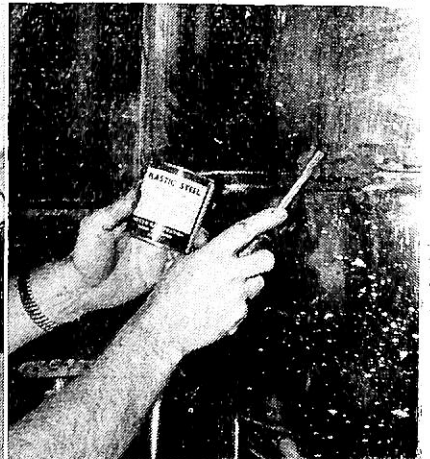
写真5 修理作業状況
