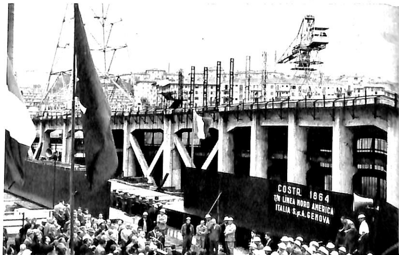
San Marco 造船所での起工式
