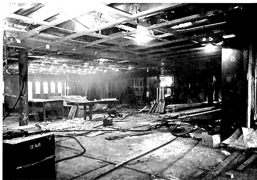
Henry Hudson Lounge の 改装工事
