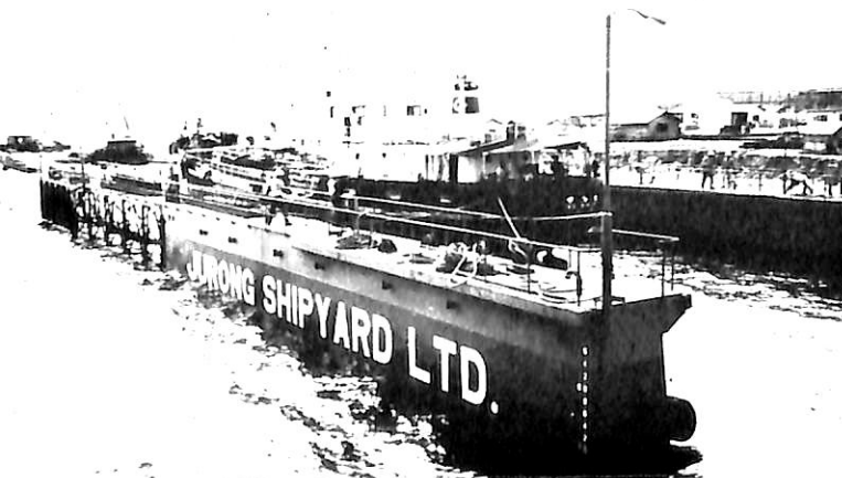
ジュロン造船所の浮ドックで工事中の甲陽丸
