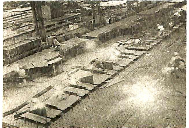
3-30図 グラビティ溶接機の使用状況
