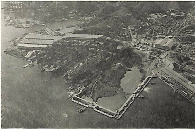
昭和39年11月11日現在のドックゲート締切り後の排水、掘削状況
