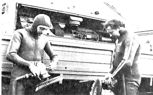
背後のローリーに乗っているアトラス・コプコ・コンプレッサーVT 6 にローター・ブラシ(直径 12')を連結する前のブラシ点検
