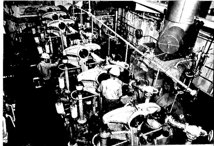
機関室内主機頂部
