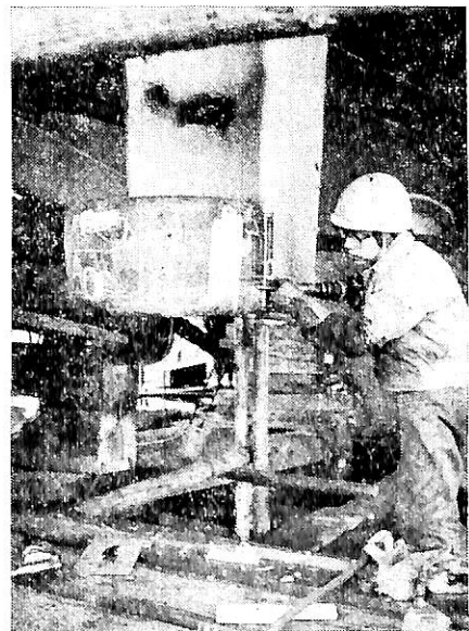
写真 3.7 舵支材の取付けが悪いと…… (舵が当たる部分の削整)
