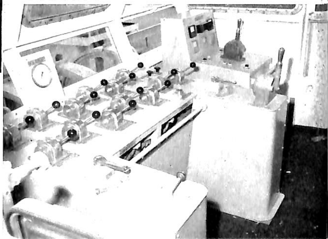
トロールウインチ操作室内（手前・トロールウインチ操作前方・15,000m測深儀操作卓）
