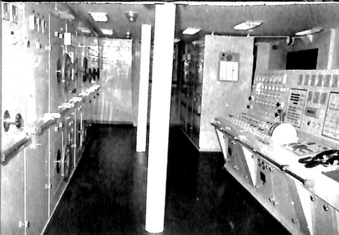
中央管制室（右側手前より中央制御盤、給電盤、中央は奥補機盤、左側は制御配電盤）
