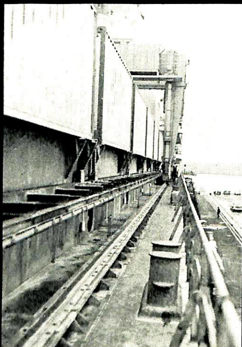
日本における最初のコンテナ船(MATSON社向)コンテナ、クレーン、船体貨油タンク内に対し Dimetcote および Amercoat 塗料施工
