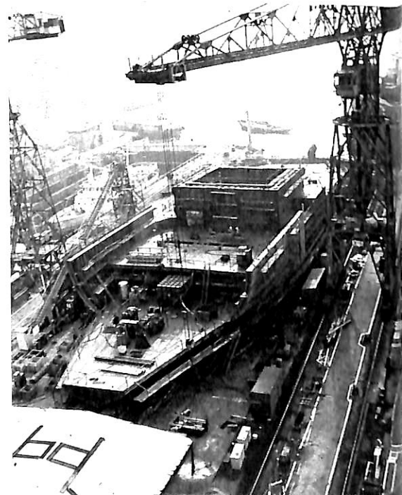
⑤ (44/1/14) 原子炉室組立完了後、前後部へ第三、第四甲板、外板等を搭載してゆく。原子炉室隔壁部は第二甲板の高さになっている。
