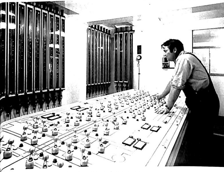
パラスト・コントロール・ルーム
