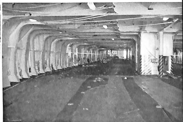
D-deck 車両甲板 (後方を見る)
