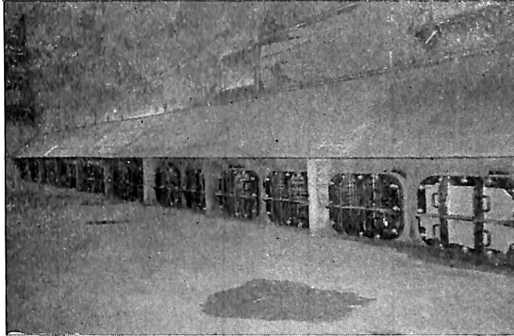
第7図 フィルター取付状態
