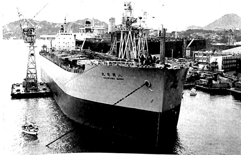
改造中の八洲川丸（船首よりみる）
