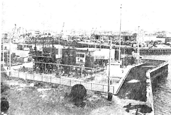
那覇港廃油処理施設
