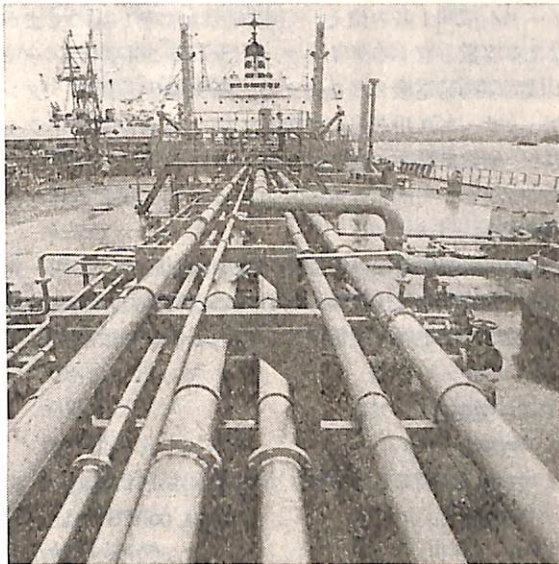
上甲板パイプライン
