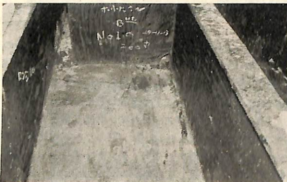
写真 3 1番カーゴ／バラスト兼用タンク船底部
