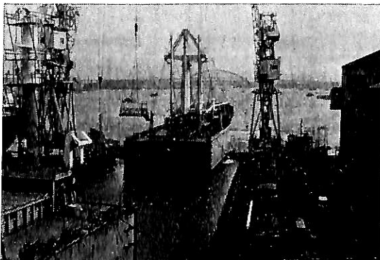
写真5 ドック内に引き入れ中の既存船体船首部
