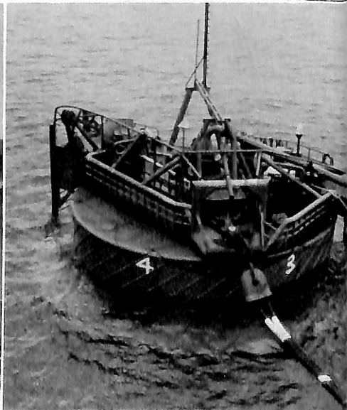
12万tの係留能力を有する一点係船ブ
