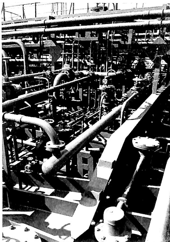
センタータンク加熱用熱交換器
