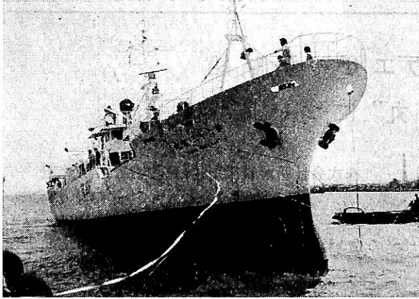
写真 2 航海時の船体抵抗と波浪中の動揺を減少させるためAW形の球状船首に更に改良を加え大球状船首形とした。
