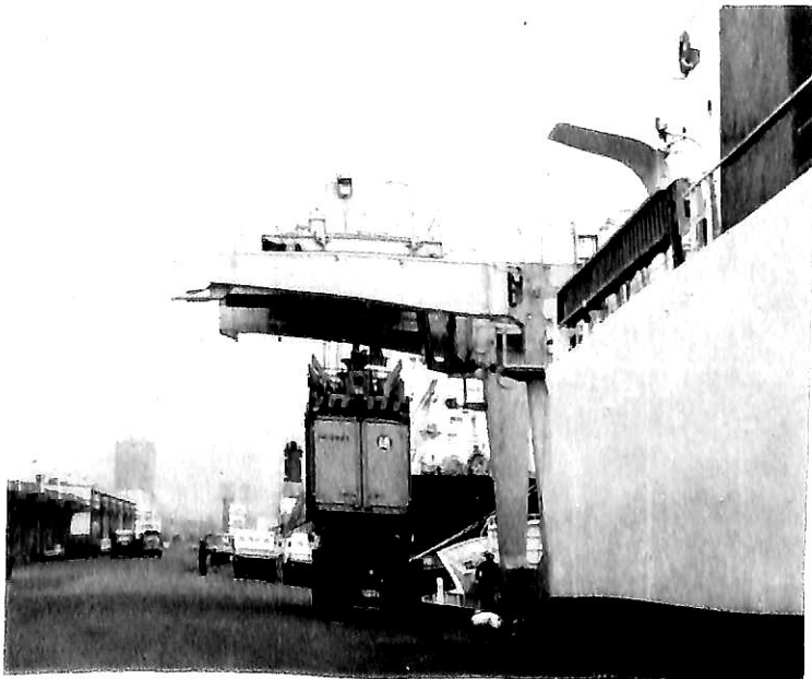
品川埠頭にて荷役中の 『ゆうふつ丸』船首方向 を見る
