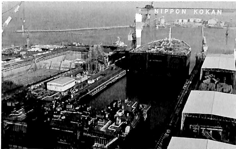
旧船体船首部 (前方) と新船体部 (手前) との接合 (55-9-中旬)
