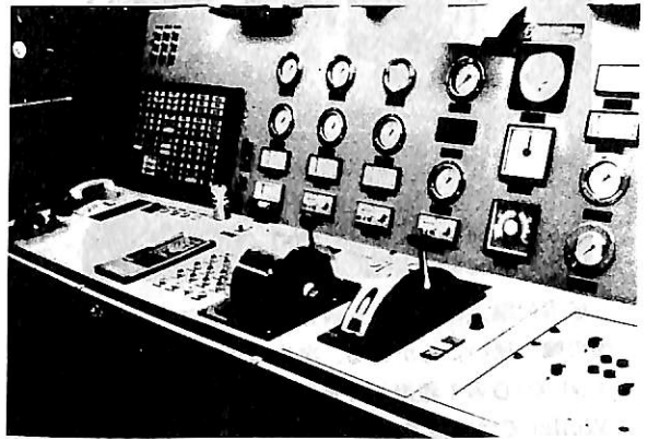
Canal Electric 社製機関制御室パネル。中央は機関回転数、CPP のピッチコントロール。装置は単純明解で、バラストシステムのダイアグラムと一列の自動警報器がついている。
