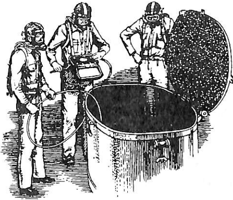
図10・2 ガス検知作業(臭いには頼らないこと)
