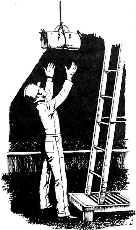
図10・1 工具はキャンバスバッグ等に入れてタンク内におろすこと
