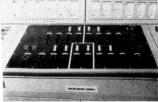
写真3 三菱-COAL MACCSの制御盤
