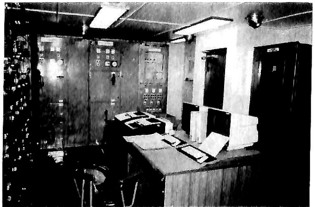
冷凍装置制御室
