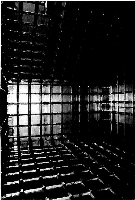
写真5 メンブレンタンク
