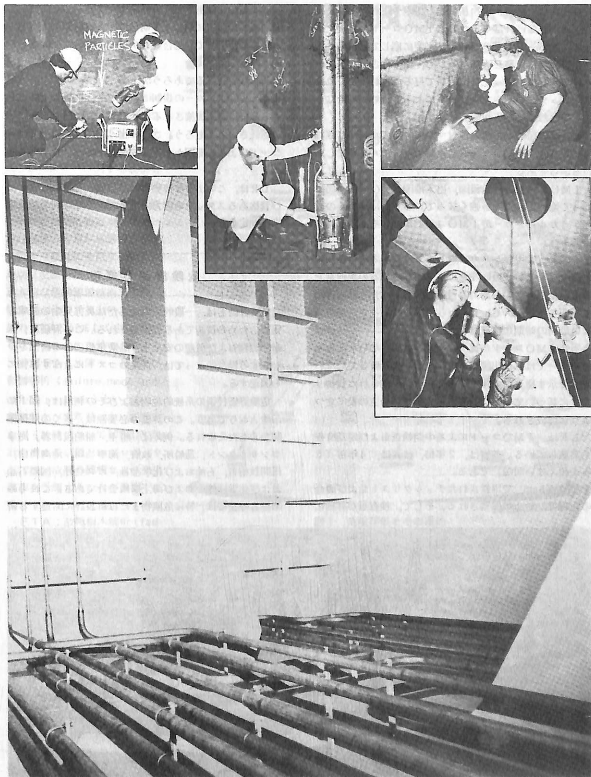
写真4 貨物タンク内およびタンク内各種の検査
